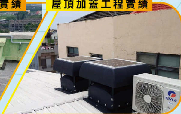
屋頂加蓋工程實績
