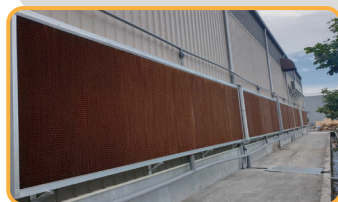
気化式冷却壁のフレームはアルミニウム合金です。
